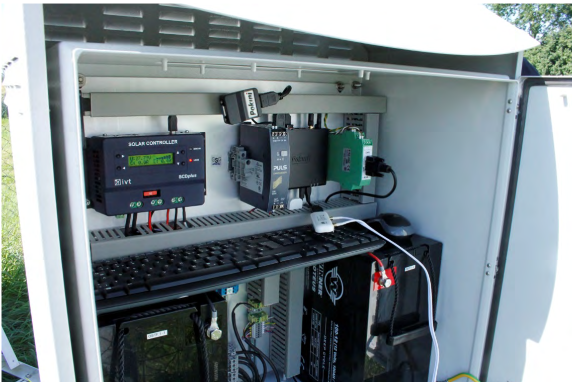
Abbildung 38: Technischer Aufbau der Solarbetriebenen Kompaktwetterstation (Foto: Christine Schröder, Ostfalia Suderburg)
